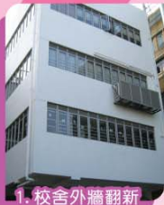
1. 校舍外牆翻新
