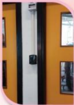
於禮堂連接廚房之出入口、廚房門及地下電梯大堂出入口安裝磁力鎖
